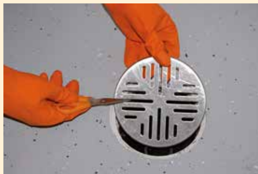
1. Nosta lattiakaivon suojaritilä pois paikoiltaan esim. saksien kärjillä.
