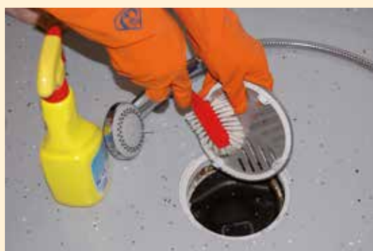
4. Pese suojaritilä molemmilta puolilta ja paina ritilä takaisin paikoilleen. Tarkista, että kaivoon jää puhdasta vettä hajulukoksi estämään viemärikaasuja pääsemästä huonetilaan.
