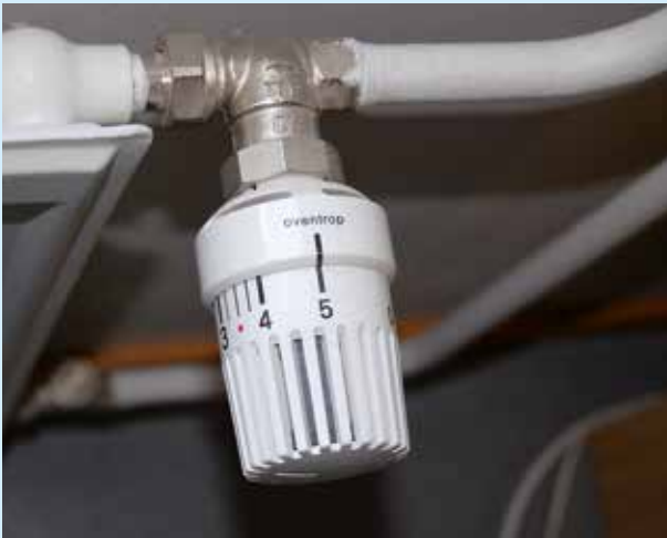
Patteritermostaattia ei saa peittää pitkillä verhoilla tai kuivumaan laitetuilla vaatteilla.
