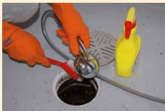
3. Pese lattiakaivo tarkoitukseen varatulla harjalla pesuainetta ja vettä käyttäen.
